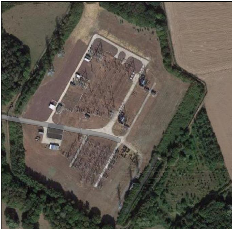
Figure 42 : Vue aérienne du poste de Longuenesse
