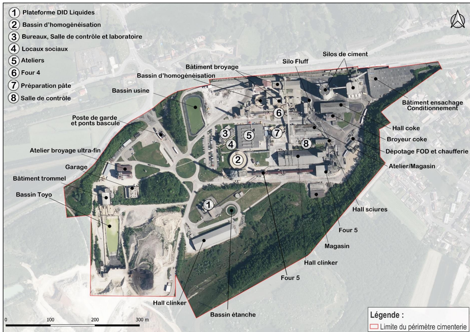
Figure 6 : Localisation des principales installations de la cimenterie de Lumbres dans sa configuration actuelle
