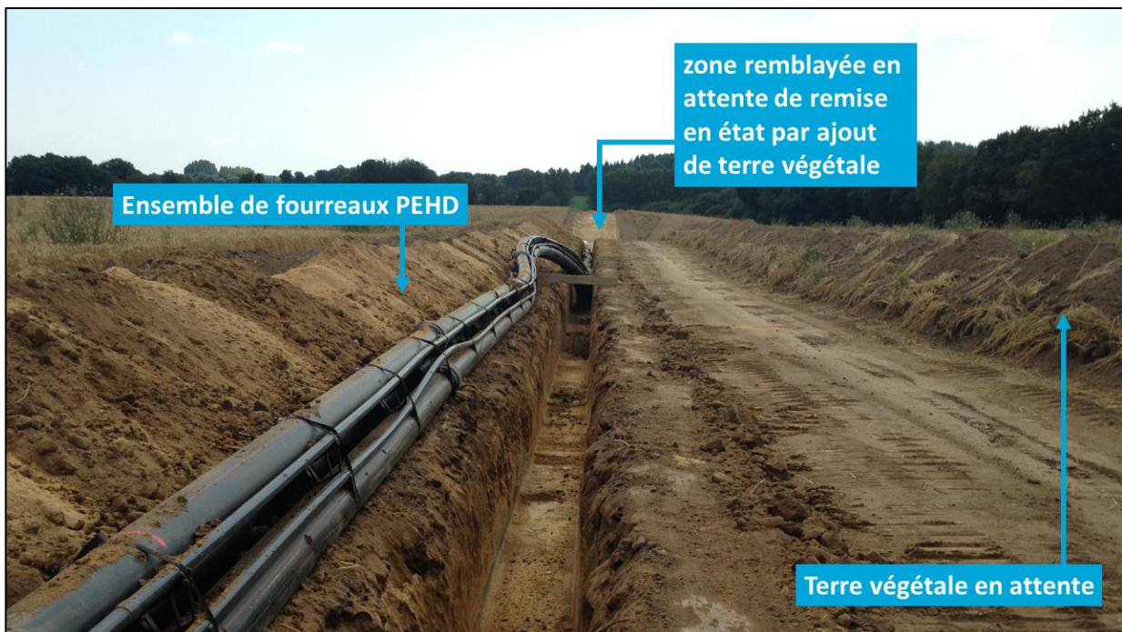
Figure 47 : Chantier de pose d'une liaison électrique souterraine en milieu agricole en fourreaux PEHD
