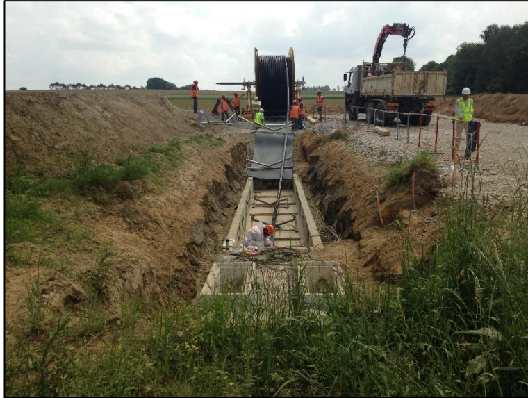
Figure 49 : Déroulage de câble depuis une chambre de jonction
